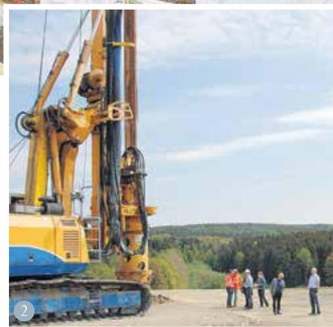
niegelände acht Brunnen bis zu einer Tiefe von 20 Metern mit einem Durchmesser von 90 Zentimetern gebohrt. Diese werden mit einem gelochten Rohr, welches ringsherum mit Filterkies
